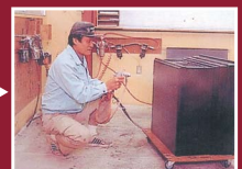
塗装仕上げ塗り
